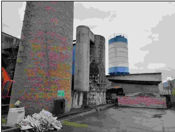
原锅炉（正在拆除）
